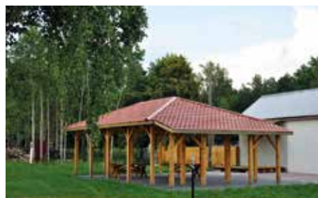
Wiaty już po zakończeniu prac na dachu
