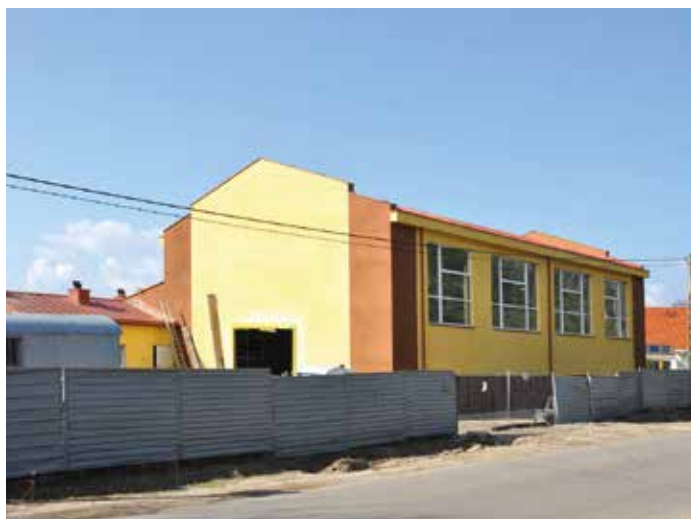
Budowa sali gimnastycznej przy Szkole Podstawowej w Białobielu – stan w kwietniu.
