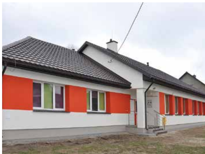
Termomodernizacja budynku świetlicy wiejskiej połączona z wymianą dachu w Durlasach – stan po odbiorze technicznym i zakończeniu prac.
