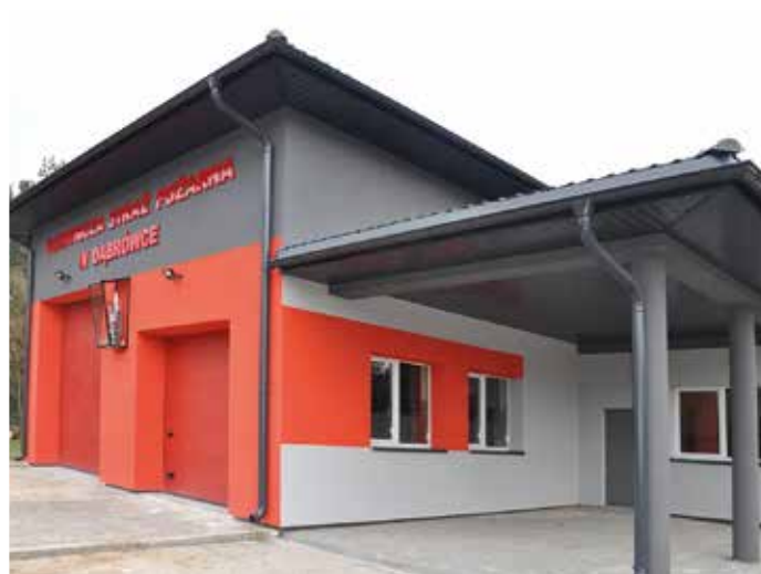
Remont remizy OSP w Dąbrówce – stan po odbiorze i zakończeniu prac.
